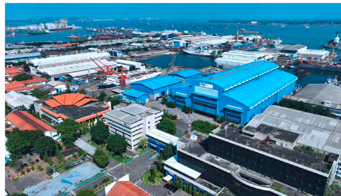
Le chantier naval de PT PAL, en Indonésie, où seront construits les sous-marins Scorpène® Evolved du programme SRI.
